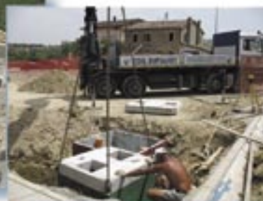
Scarico e installazione degrassatore con nostra autogru
